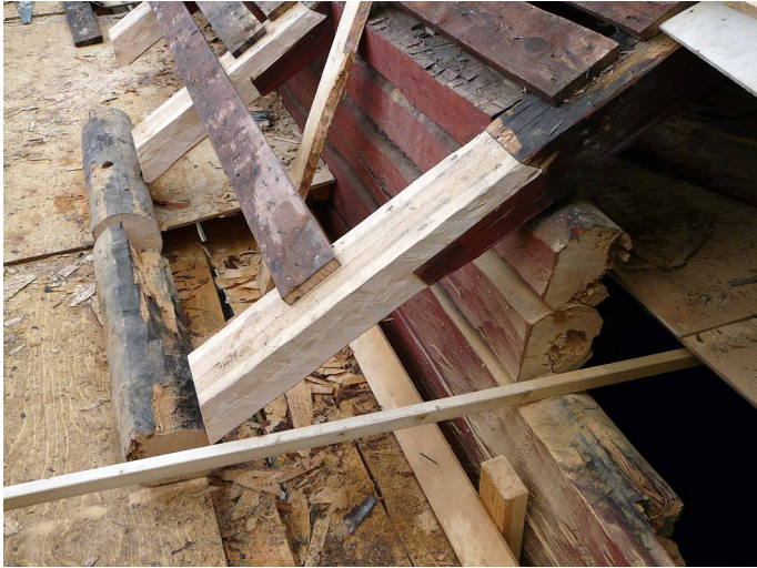
Kattovasan kiilava lapaliitos Mäntyharjun Iso-Pappilan riihen kattovasassa. Kuvaaja Hanna Kemppainen/Etelä-Savon ely-keskus, 17.5.2011.
