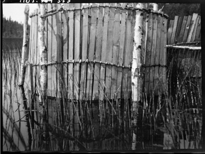
Raamisahatuita laudoista tehty suuri liistekatiska Juvalla vuonna 1930 . Liisteet on sidottu vitsaksilla ja katiska on tuettu ympärille juntattuihin koivuihin. Savonlinnan maakuntamuseon kuva-arkisto, 1105: 353–353, kuvaaja Jussi Turunen.
